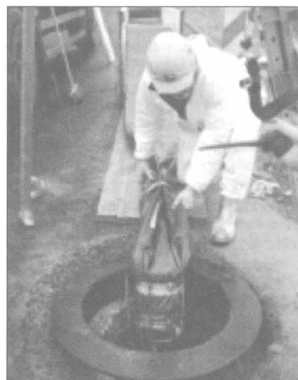
Fig. 2.13.10. Tragerea cu trolul prin puț a furtunului pliat
